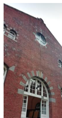
国登録有形文化財の旧端出場水力発電所。
