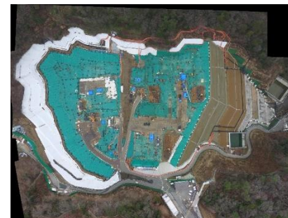
特定廃棄物埋立処分施設の様子
