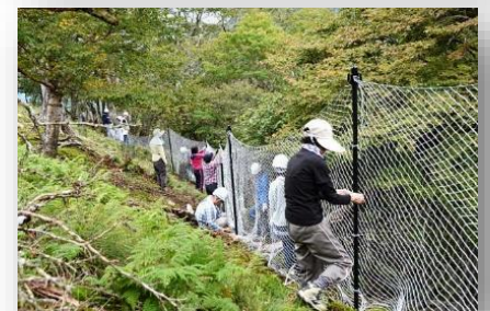
5 月の防護柵設置の様子
